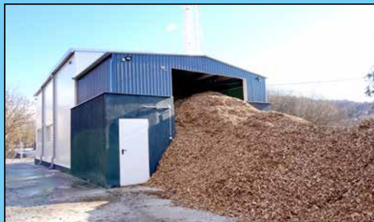
A megvalósult fejlesztéssel a kiválasztott önkormányzati épületek, egyéb épületek, közcélú létesítmények meglévő fosszilis hőenergia fogyasztása csökkenni fog, ezáltal jelentős rezsicsökkentés érhető majd el a biomassza kazán használatával.
