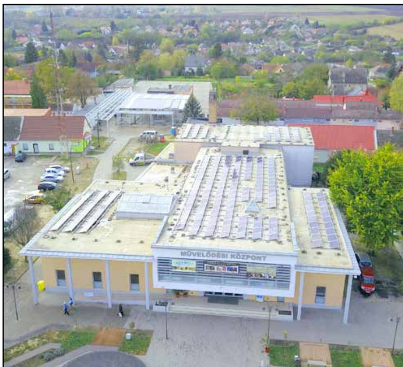
A TOP-3.2.1-15-TL1-2016-00019 „Önkormányzati épületek napelemmel való ellátása” című projekt keretén belül a művelődési központ tetején helyeztek el 200 darab napelem táblát, mintegy 32 millió forintból.
